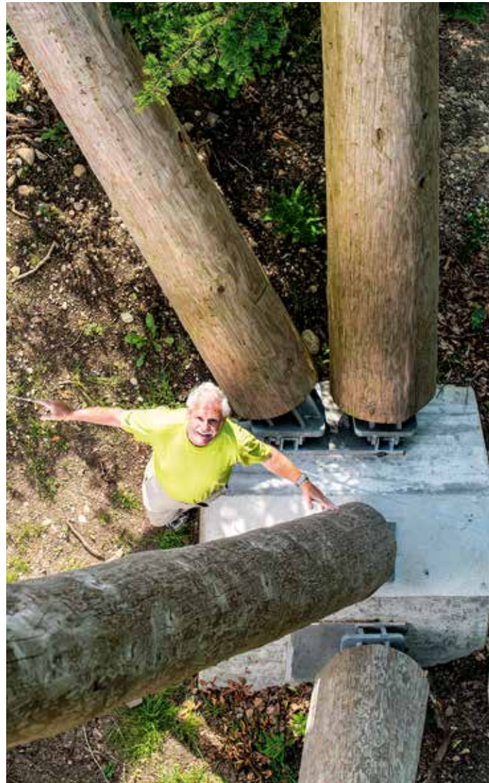
Zimmermann Fritz Rutz erklärt die ausgeklügelte Holzkonstruktion mit den mächtigen Rundholzstützen.
