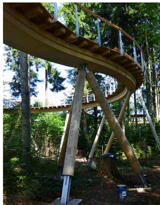
Die Stützen sind über Flaschen mit dem Steg verbunden und stehen auf bis zu 220 kg schweren Stahlplatten.
