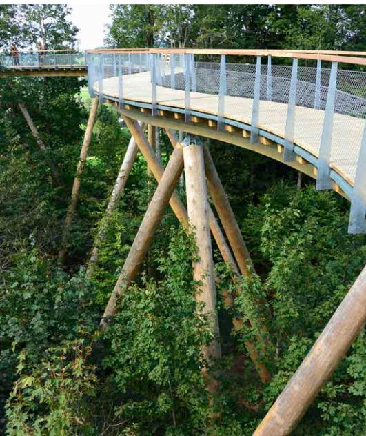
Der Steg steht auf bis zu 16 m langen Stützen, die aus Vollholz gefertigt wurden.
