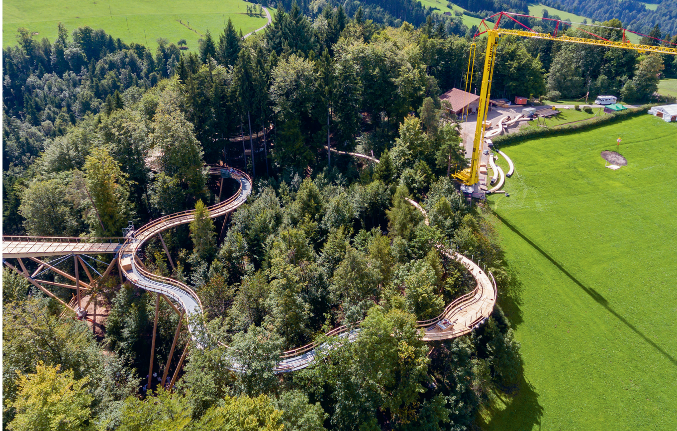
Der Baumwipfelpfad im Neckertal besteht aus 84 Stützen und 84 Elementen. Der 500 Meter lange Steg schlängelt sich auf bis zu 16 Meter Höhe durch die Baumkronen.
