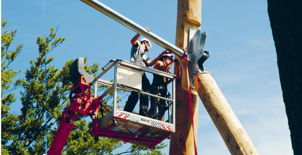
Die Monteure bringen die Zugstangen an der Plattformkonstruktion an. Das Arbeiten mit der Hebebühne, mit der Persönlichen Schutzausrüstung gegen Absturz (PSAgA), sowie das Bedienen der Hebebühne dürfen nur mit geschultem Personal erfolgen.
