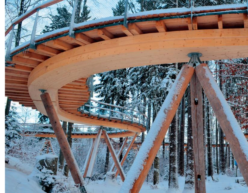
500 Meter lang ist der neue Baumwipfelpfad, der sich durch die Bäume im Steinwäldli schlängelt. Getragen wird er von 84 Stützen.
